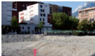
Rénovation urbaine dans le quartier Mistral
