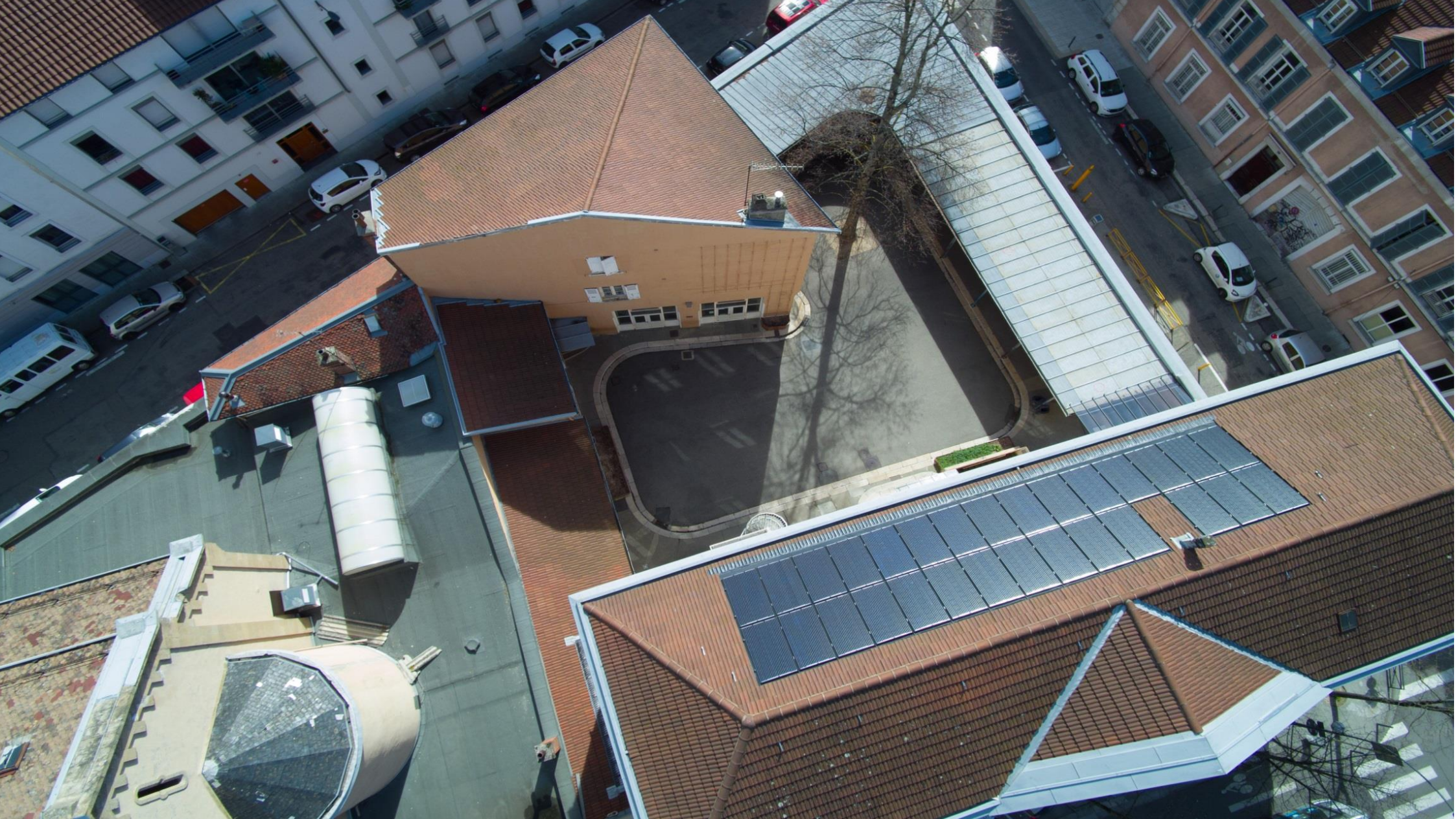
Installation de panneaux photovoltaïques sur le toit de l'école Menon dans le cadre du projet « Solaire d'ici »
