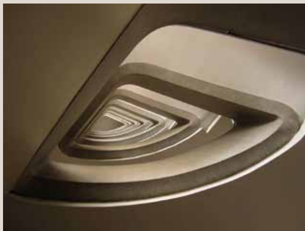
Escalier béton, immeuble rue Thiers
