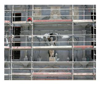
Avant de rejointoyer les pierres, il faut dégarnir l'ancienne matière, souvent pulvérulente. On utilise ensuite un mortier de chaux teinté pour obtenir un coloris identique. Le joint doit affleurer le nu du parement.
