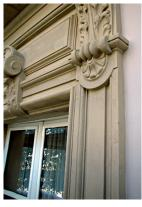
L'emploi de résines synthétiques ou de ciment portland artificiel est interdit car ces matériaux ont des propriétés plastiques et physico-chimiques incompatibles avec les anciens ciments.
