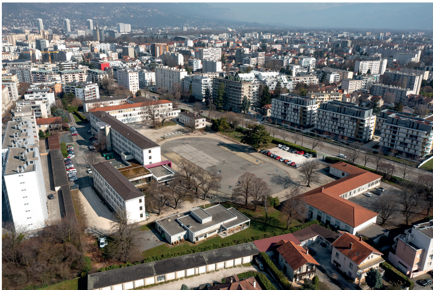
INSPé © drone, Ville de Grenoble
