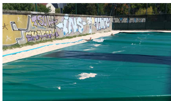
Bâche de stockage
