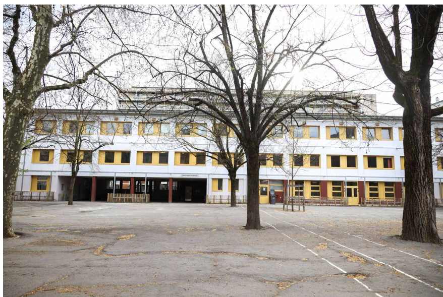
Cour élémentaire avant travaux © Auriane POILLET, Ville de Grenoble 2023
