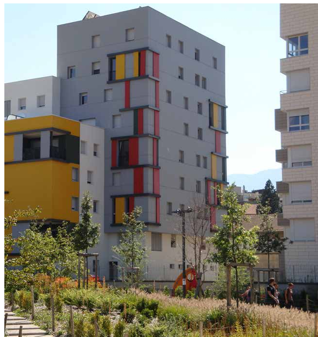
CDC Habitat social – Résidence les Alpines - Les Alpines GRENOBLE – 33 logements
